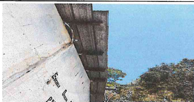
Foto 5: Lámina de las aulas parte de atrás
